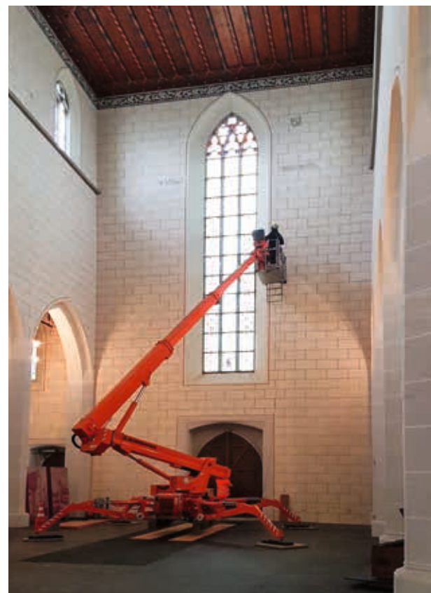
Nichtinvasive Sondierungen des Natursteinmauerwerks.
