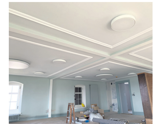
Anspruchsvolle Gipsarbeit, kompetent ausgeführt. FOTO: BÄR AG, ZOFINGEN
