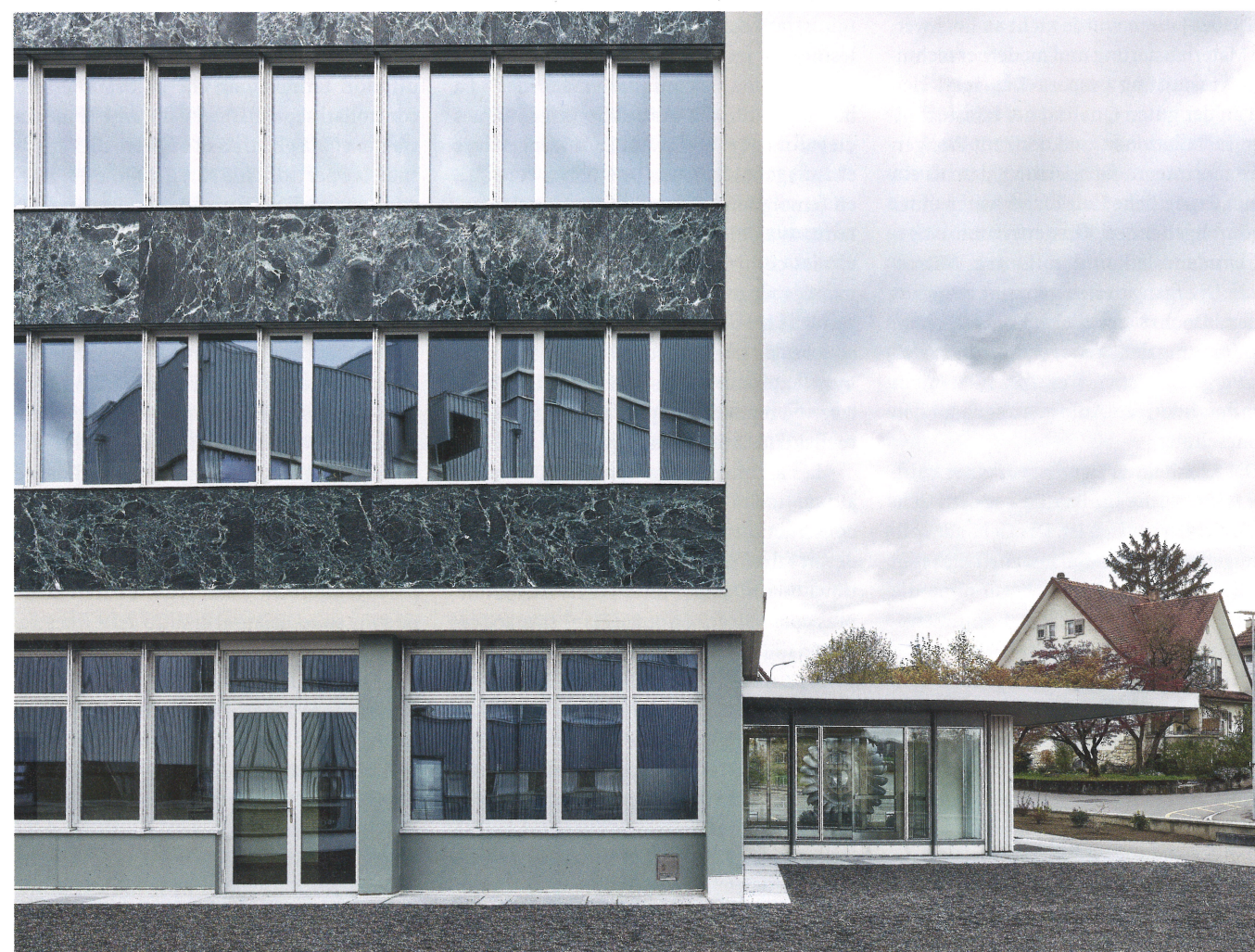
6 Ansicht der Brüstungsbänder aus Marmor. Vue des contrecœurs en marbre. Vista dei parapetti realizzati in lastre di marmo.
