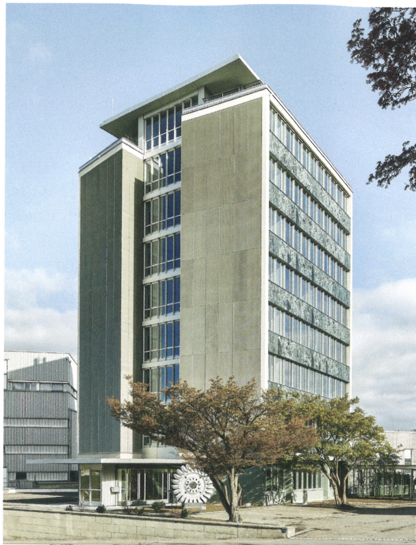
2 Neue Steinplatten, montiert mit einem Vorhängesystem, lassen die Fassade wie damals, vor 70 Jahren erscheinen.
